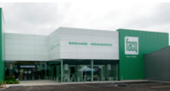
room en sanicenter.
